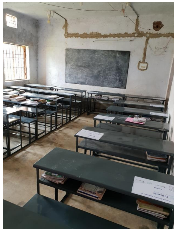
Neue Tische und Bänke für den Klassenraum. Über der Tafel ist die neu verlegte Stromleitung sichtbar.
